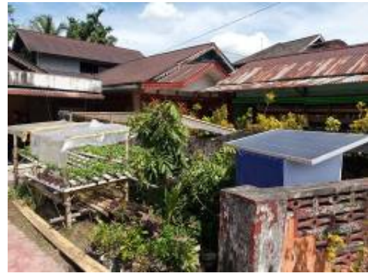
Gambar 2. Instalasi panel surya pada sistem hidroponik
