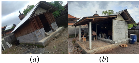
Gambar 9. Kandang Sebelum (a) dan Sesudah (b) Penambahan Area Baru
